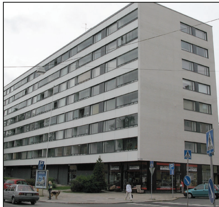
Turussa Eerikinkadulla sijaitsevaan kiinteistöön on tehty parvekekorjaus, ja julkisivulevytyks, minkä lisäksi ikkunat ja ovet on vaihdettu.
