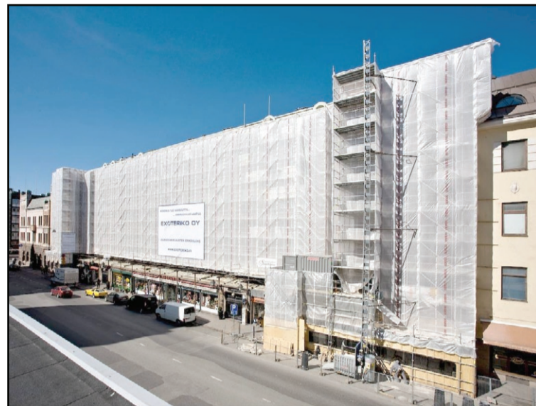
Linnankadulla sijaitsevan arvokiinteistön julkisivukorjauksen tulokset paljastuvat syyskuun lopulla.
