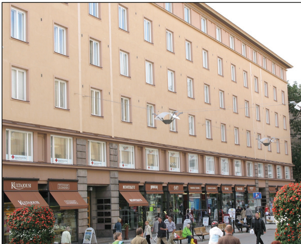
Turussa kävelykadun varrella sijaitseva talo sai uuden, tyylikkään ilmeen uusintarappauksen ja parvekekorjausten ansiosta.
