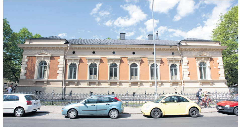
J. Martti toimi pääurakoitsijana myös Arkkipiispantalon vaativassa saneerauksessa.
