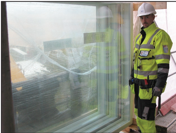
Mika Wahlstén valmistautuu asentamaan massiivista ikkunaa saneerattavaan kerrostalokohteeseen.
