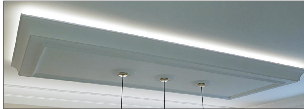
Keittiösaarekkeen yläpuolella olevan kattomoduulin led-valo tulee kipsistä valetun listan takaa. Reunassa myös boordi sekä kipsirosetit.
