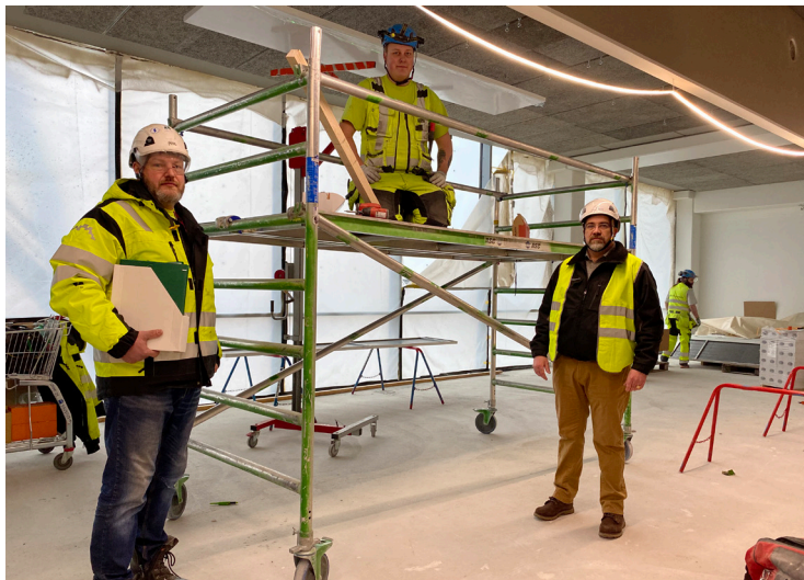
Infra-Cityn työmaalla Atte Lehtilä (vas.) ja Mikko Tykkyläinen, telineellä Joni Honkasalo ja taustalla Jussi Huhtamäki.
